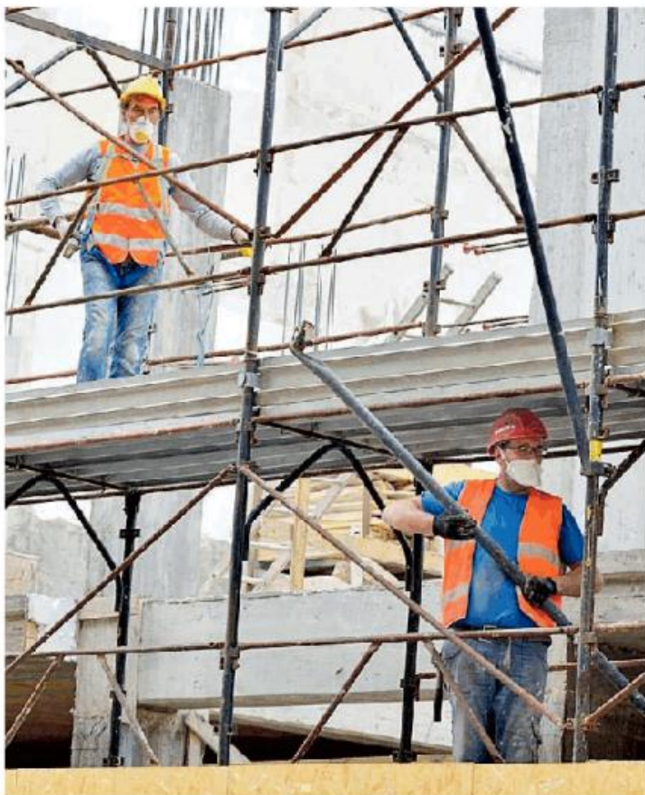
Al via i controlli nei cantieri che utilizzano il superbonus
